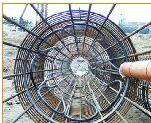
Detalle de la armadura y colectores geotérmicos de un pilote termoactivo. Fuente: Enercret
