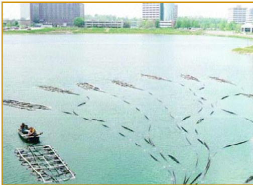
Instalación de racimos de colectores geotérmicos en un embalse para aprovechamiento geotérmico. Fuente: McQuay Internacional
